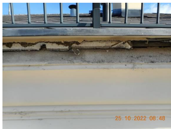
Poškození čela římsy – trakt C
