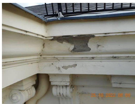
Lokální poškození spodní části římsy – trakt D
