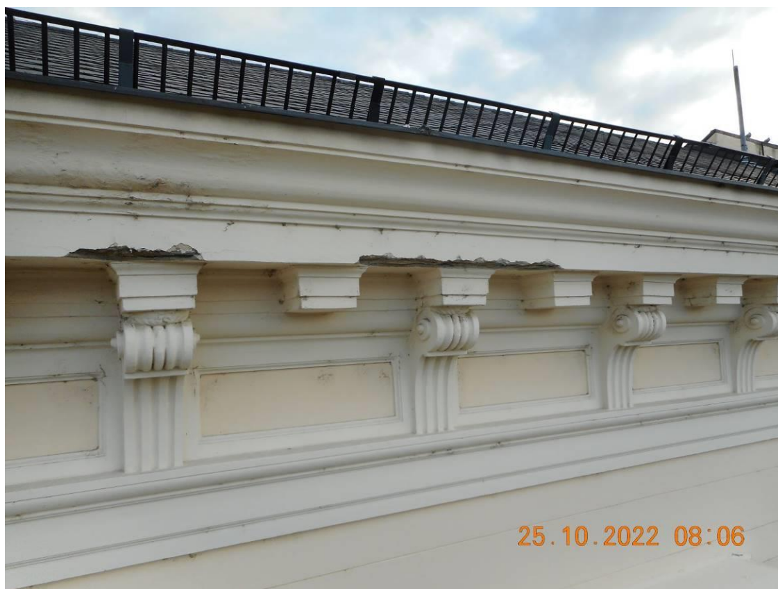
Lokální poškození spodní části římsy – trakt D
