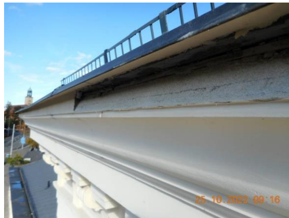
Poškození čela římsy – trakt C
