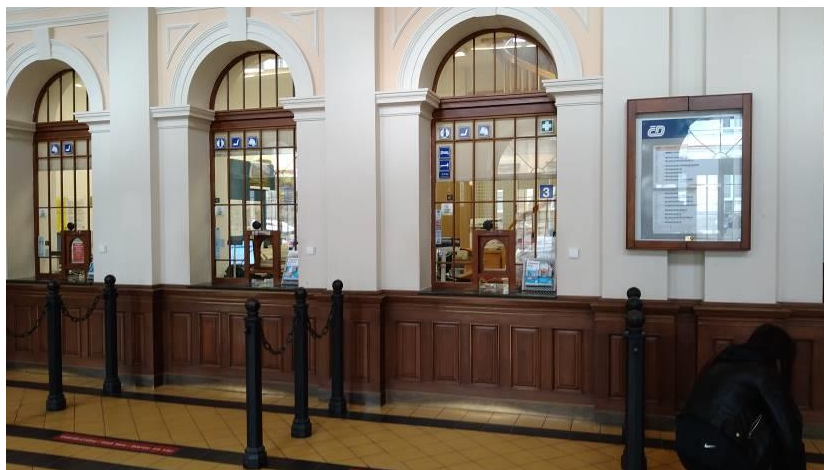
Stávající stav - dřevěný obklad, sádrové římsy
