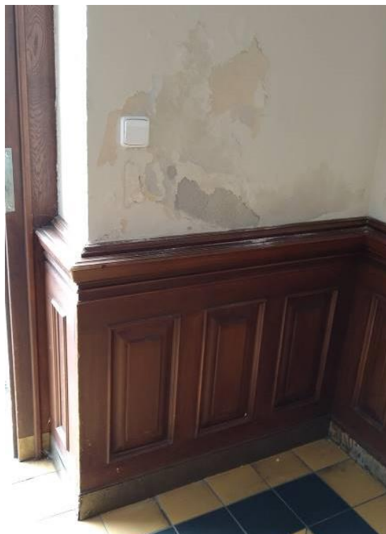
Stávající stav – foto vlhkého zdiva m.č.122
