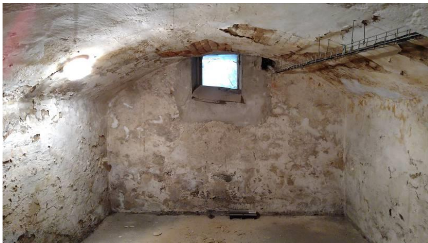
Stávající stav – 1.PP – prostor CO krytu – silně zavlhlé zdivo
