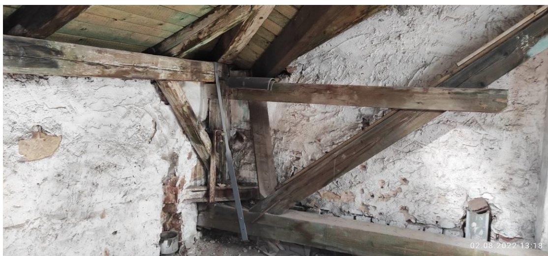
Foto konstrukce krovu – Trakt E – poškození dřevěných prvků krovu
