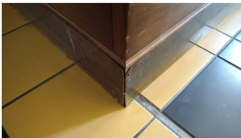
Stávající stav – okopový plech – typické poškození
