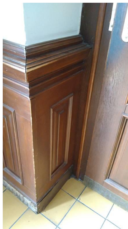
Stávající stav – poškození obkladu
